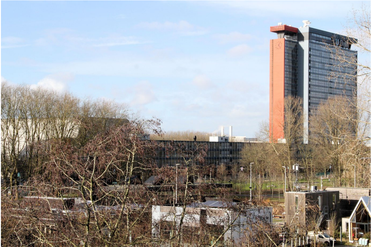
Faculteit Elektrotechniek, Wiskunde en Informatica van de Technische Universiteit Delft. Op de voorgrond The Green Village. Februari 2025.
