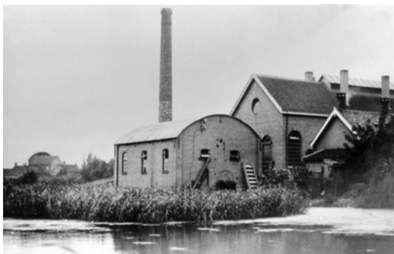
Elektriciteitscentrale van de N.V. Elektrische Verlichting 'Kinderdijk' te Kinderdijk met het ronde plaatijzeren dak. Rechts: Ontwerptekening Electricische inrichting voor 350 gloeilampen.
